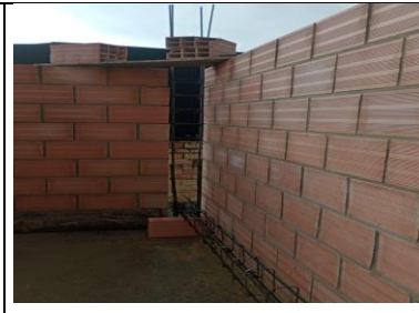
Fotografía 3. Mampostería en bloque #5 y armado de columnas 12x20
