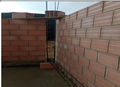
Fotografía 1. mampostería en bloque # 5 eje f 1-2 ya armado de columnas 12x20
