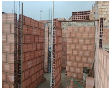
Fotografía 2. mampostería en boque # 5 eje 1-1 y armado de columnas 12x20
