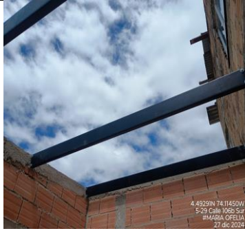
Fotografía 2. Perfilera metálica en C en cubierta en ejes (2-3) entre (B-D).
